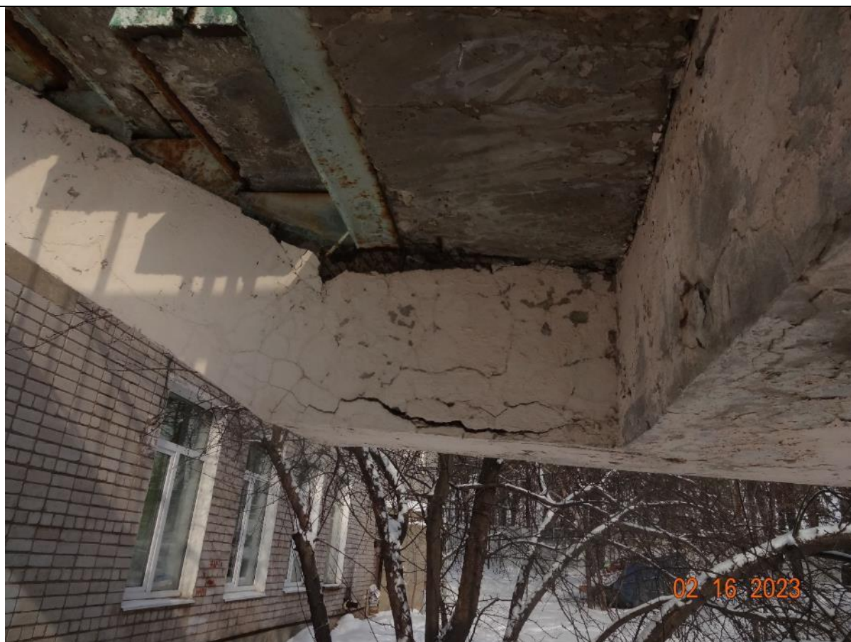
Рисунок Д10. Обрушение защитной штукатурки стальных косоуров
