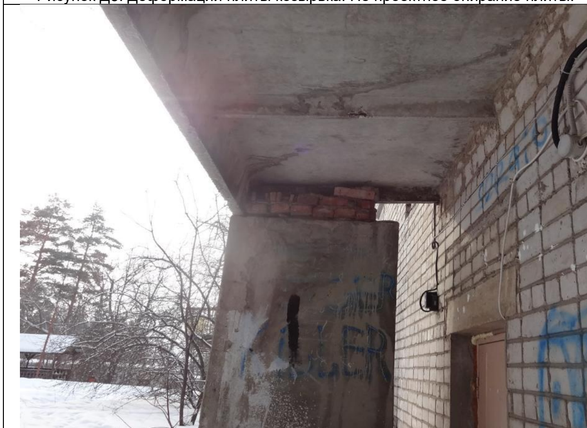
Рисунок Д9. Разрушение кладки на опоре плиты козырька
