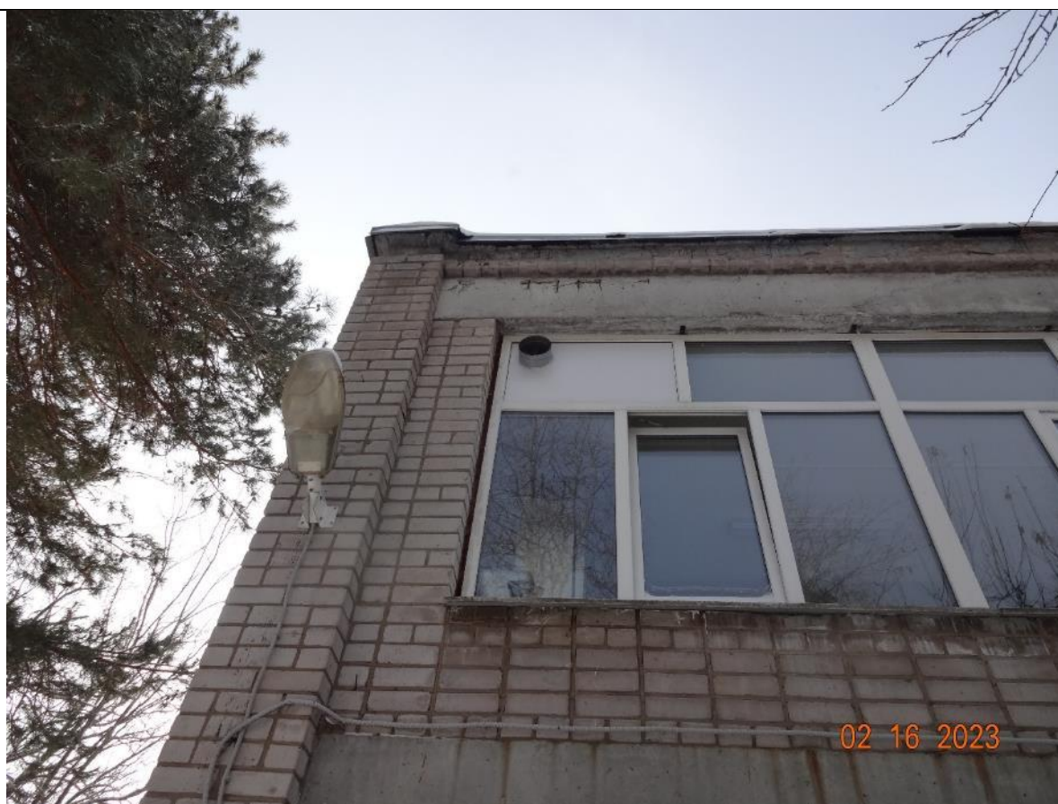
Рисунок Д7. Коррозия кирпичной кладки в подоконной части стен по оси Д/7-8
