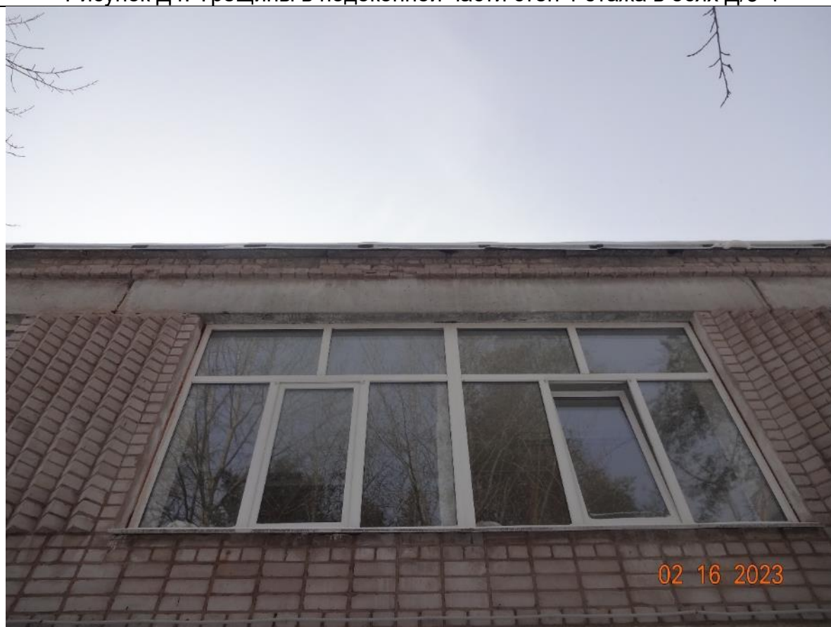
Рисунок Д5. Коррозия кирпичной кладки в карнизной части стен по оси Д/5-7
