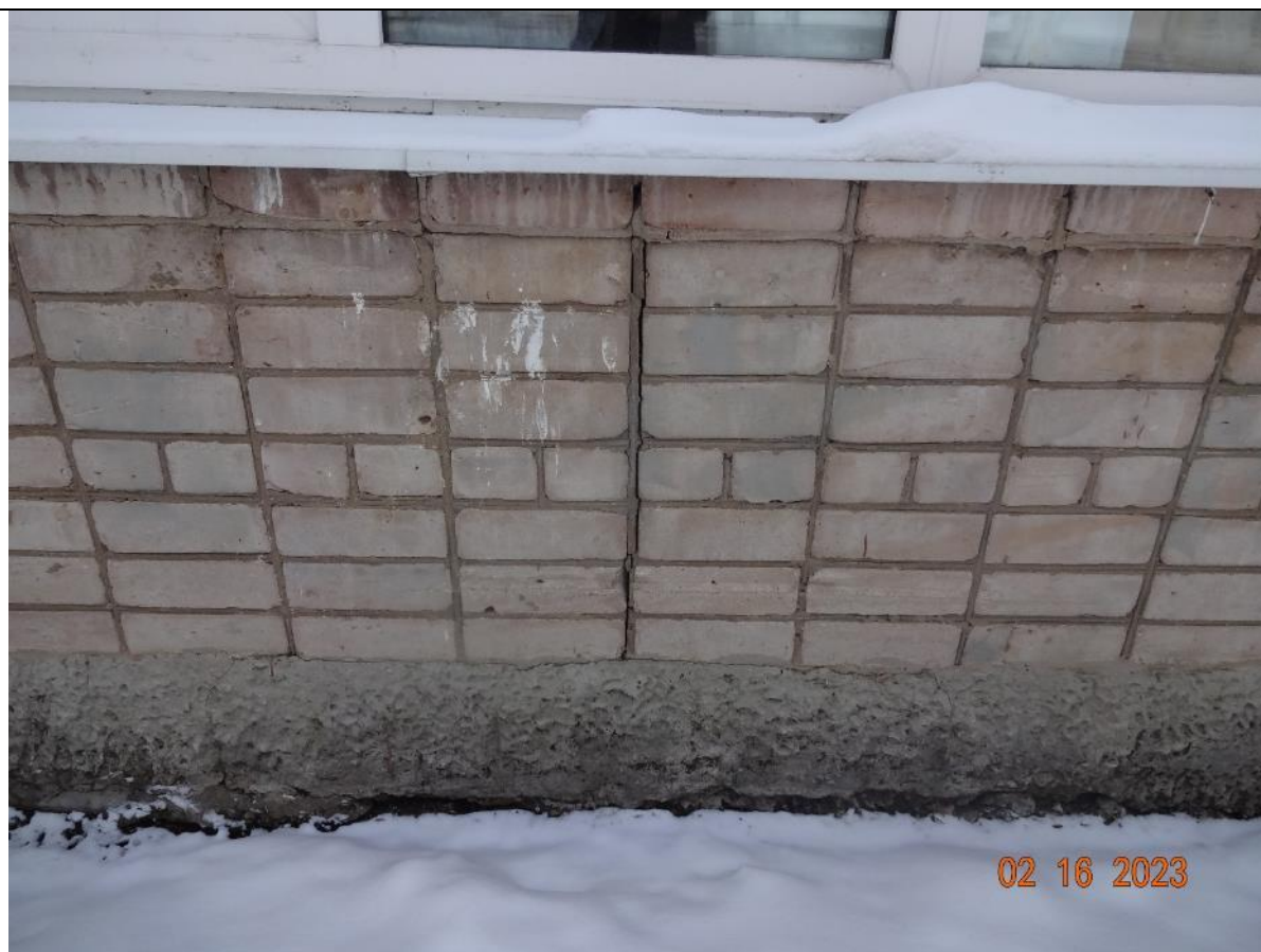
Рисунок Д4. Трещины в подоконной части стен 1 этажа в осях Д/3-4
