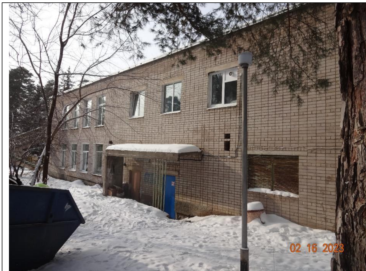
Рисунок Д8. Деформации плиты козырька. Не проектное опирание плиты.
