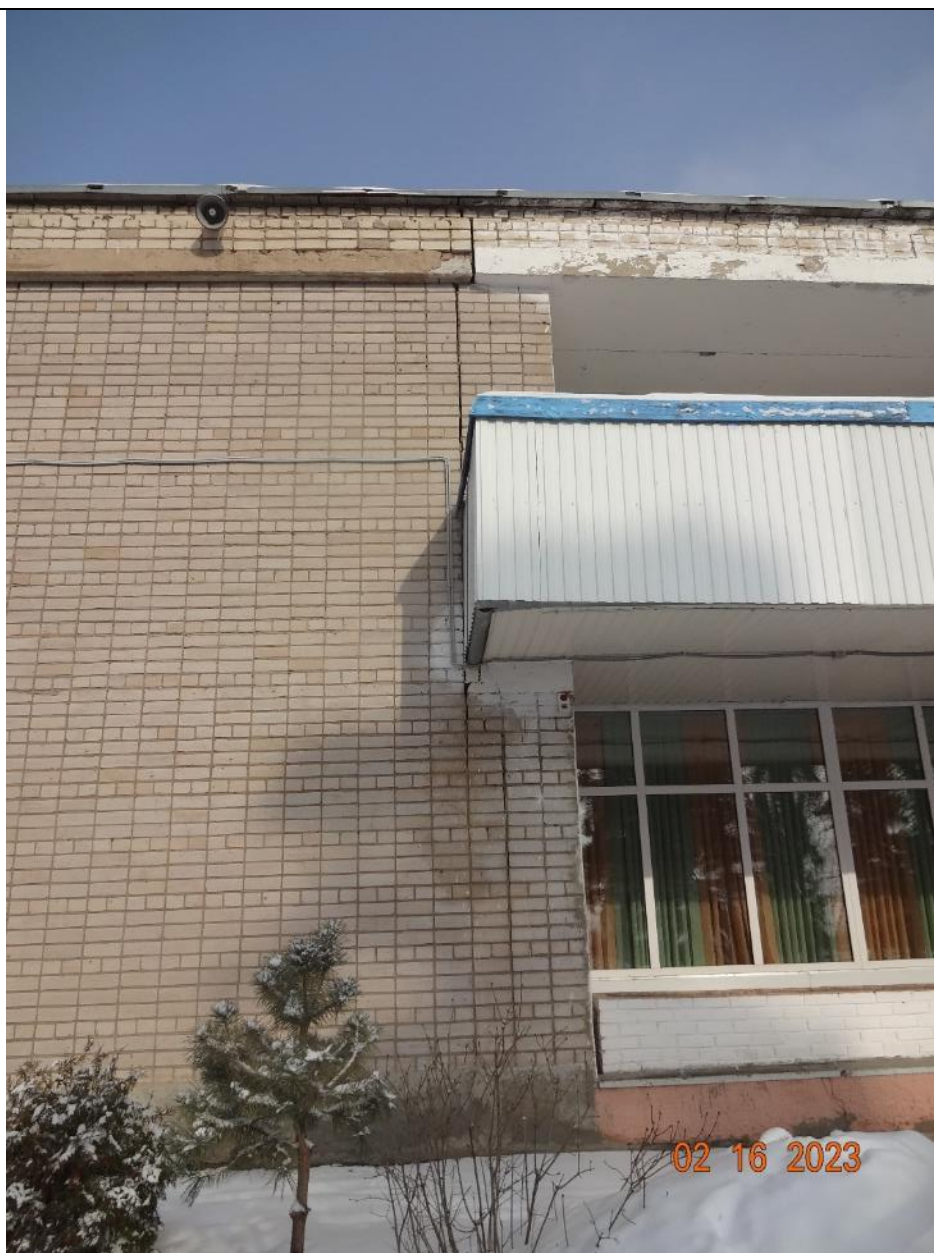
Рисунок Д1. Вертикальная трещина в наружной стене в осях А/1-3 Следы замачивания и коррозии кладки
