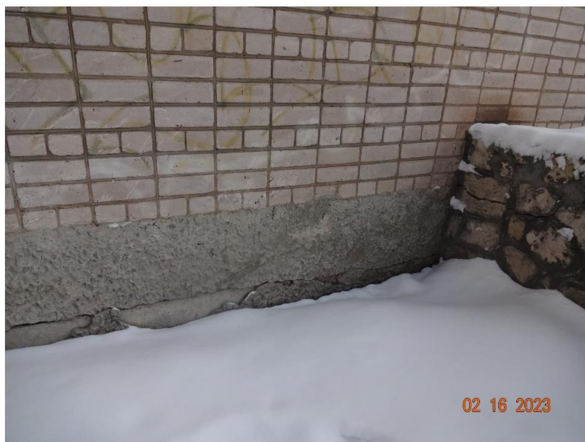
Рисунок Д3. Отсутствие гидроизоляции цоколя повсеместно. Разрушение лицевого слоя штукатурки
