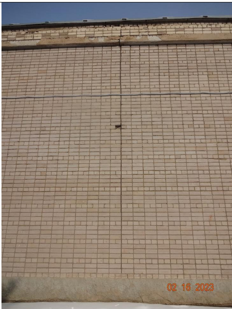
Рисунок Д2. Вертикальная трещина в наружной стене в осях А/1-3. Следы замачивания и коррозии кладки
