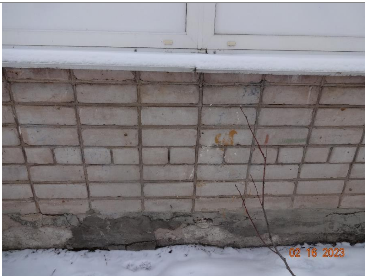
Рисунок Д6. Трещины в подоконной части стен 1 этажа в осях Д/5-7
