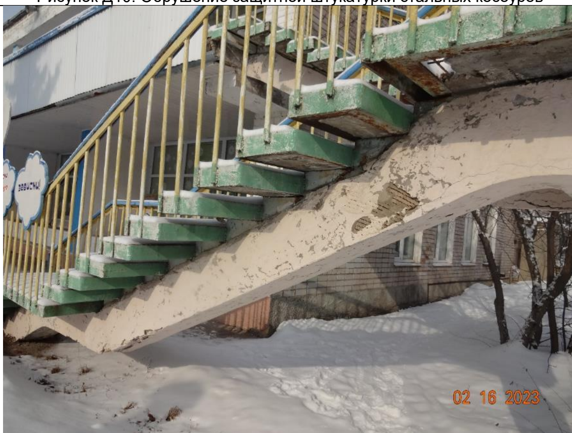
Рисунок Д11. Разрушение сталебетонных ступеней и площадки наружной лестницы
